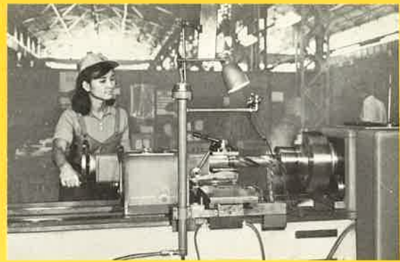
リトラクタに二速切換装置を組合せることにより、大径 のドリル加工が極めて容易にできます。
