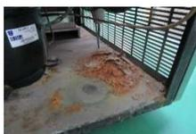
冷媒配管結露によるサビ有り
